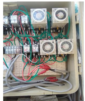
ハウスの自動開閉機はシーケンサで作成し、時刻と温度と動作時間で設定しています。
