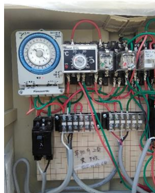
ハウスの自動開閉機はシーケンサで作成し、時刻と温度と動作時間で設定しています。
